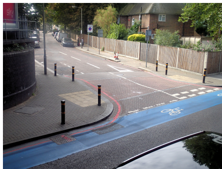
新しく設置された点字ブロックや車止め (2012年9月12日ロンドン近郊で撮影、著作権フリー)
